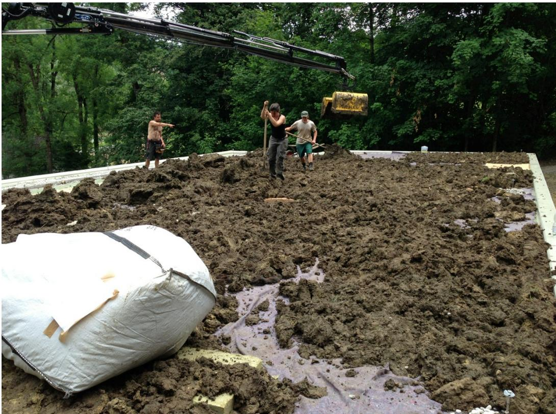
Abbildung 6: Auf die verlegten Speichermatten wurde eine Schicht von ca. 10 cm Oberboden verteilt
