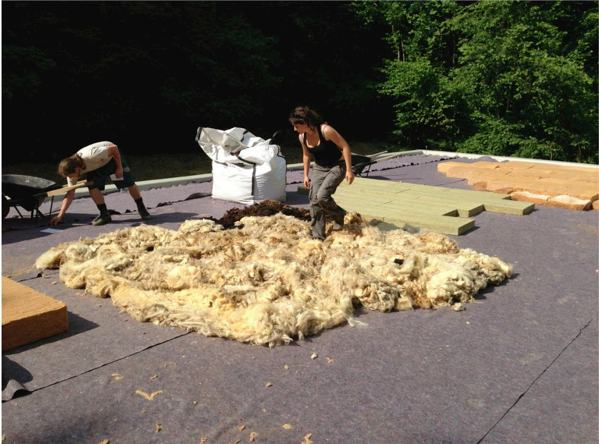
Abbildung 5: Nach dem Ausbringen von Schutzvlies wurden die Speichermatten und Schafwolle verlegt
